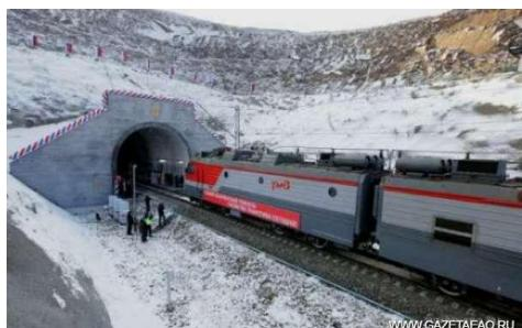
Два железнодорожных однопутных тоннеля расположены в отрогах Хинганского хребта между станциями Ударный и Лагар-Аул на 8205-8207 километрах по Транссибирской магистрали. Длина первого сооружённого тоннеля 1260 (используется под нечётный путь), длина второго 1278 метров (чётный путь). Оба тоннеля входят в число так называемых Хинганских тоннелей. Первый тоннель строился в 1912-1914 годах, второй сдан в эксплуатацию в июле 2006 года.
